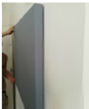
Hæng panelet op i montagebeslagene i skinnerne på bagsiden af panelet.
