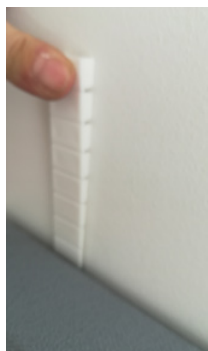
Dersom man ønsker at sikre mod demontering, sættes der 2 stk. kiler ind i toppen af panelet mellem væg og panel. Evt. overskydende kile skæres af i flugt med overkanten af panelet.
