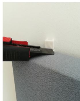
Dersom man ønsker at sikre mod demontering, sættes der 2 stk. kiler ind i toppen af panelet mellem væg og panel. Evt. overskydende kile skæres af i flugt med overkanten af panelet.
