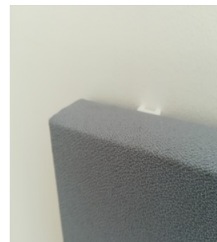
Dersom man ønsker at sikre mod demontering, sættes der 2 stk. kiler ind i toppen af panelet mellem væg og panel. Evt. overskydende kile skæres af i flugt med overkanten af panelet.
