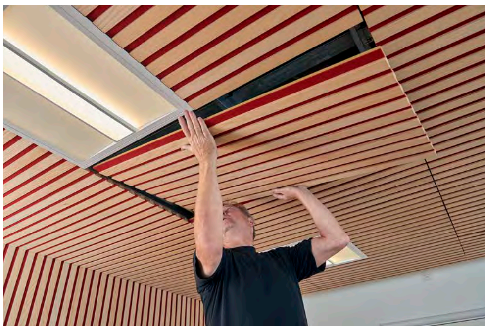
Det sidste panel monteres.
